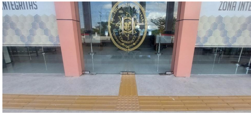
Gambar 5.54. Guiding blocks sebagai alat bantu penunjuk arah bagi tuna netra
